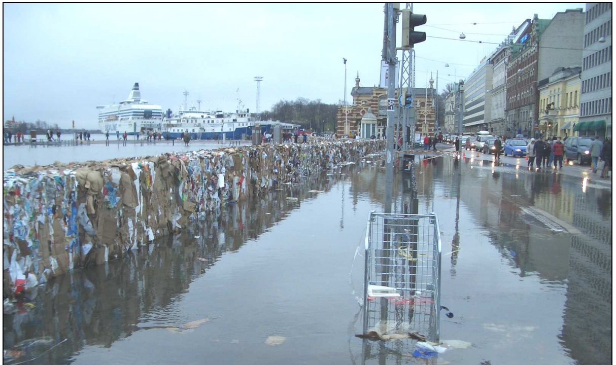
Kuva 15. Helsingin kauppatorin suojaaminen tilapäisten tulvasuojarakenteiden avulla. (Kuva: Helsingin Satama).
